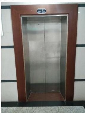
圖 6 圖書館舊館電梯候梯廳
