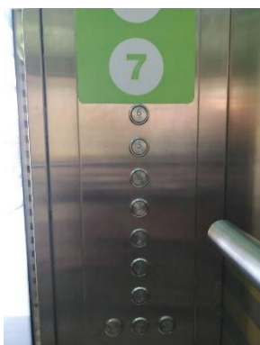
圖 9 綜合樓 A 棟電梯盲文層按鈕
