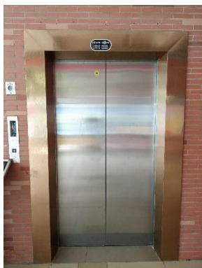
圖 2 第四教學樓電梯
